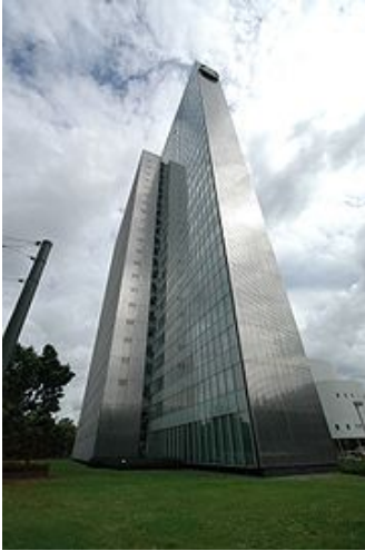
Das Dreischeibenhaus in Düsseldorf, Verwaltungsstandort von ThyssenKrupp
